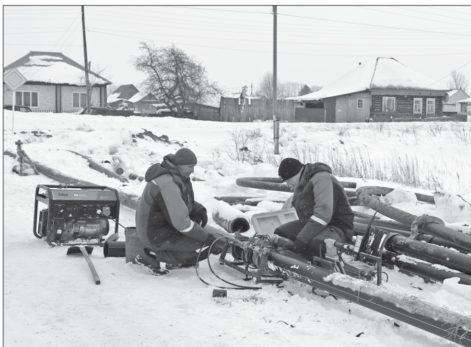
■ На переулке Первомайском в Кожевникове ведутся работы по строительству газопровода.
